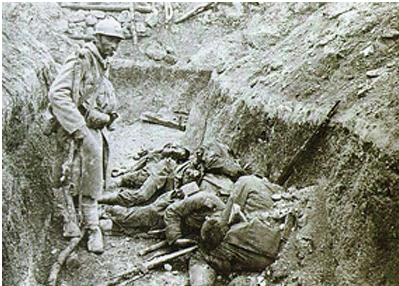
La « vraie » guerre, tranchée prise à Souain
