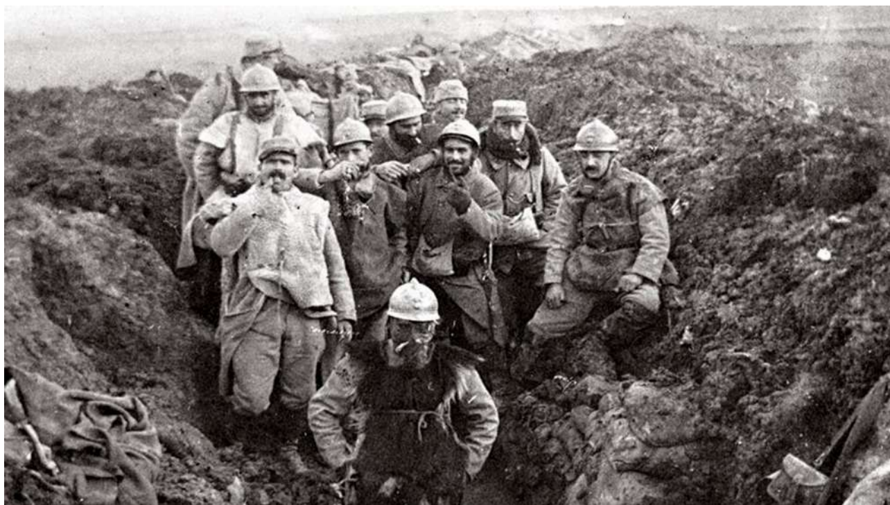
Territoriaux dans une tranchée
